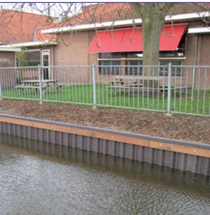
De donkerbruine slijtvaste toplaag met een unieke UV bescherming geeft de garantie voor een levensduur van minimaal 50 jaar.
